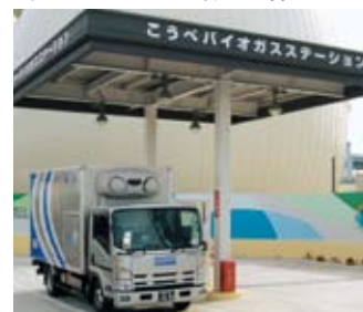
バイオガスステーション
